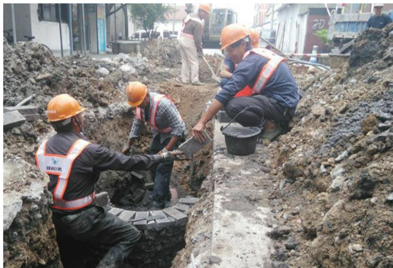
5月23日下午，柯桥排水公司工作人员在华舍街道沙地王村内忙着砌窨井、铺设生活污水管线。该村新建生活污水泵站4座，配套管线3公里，建成后，生活污水将统一纳管排放，村内水环境将得到有效改善。
